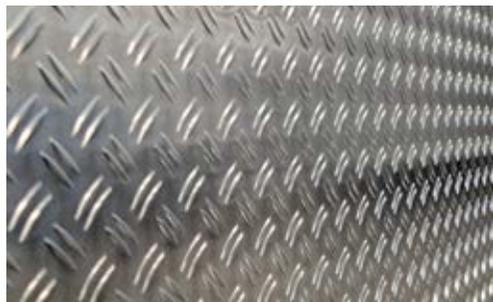
Plancher avec revêtement en tôle de plaque ondulé en aluminium
